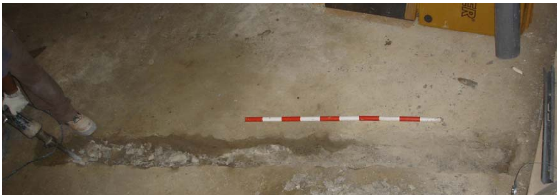
Foto general de la rasa 2 de serveis, en ple procés d'obertura.
