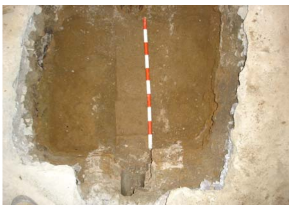
Aspecte final del rebaix practicat on s'ha bastit l'arqueta de serveis prevista pel projecte de l'obra.
