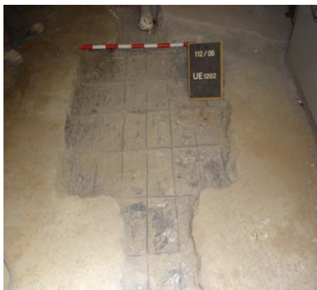
A l'esquerra la U.E. 1202, és ben visible la malla electrosoldada
