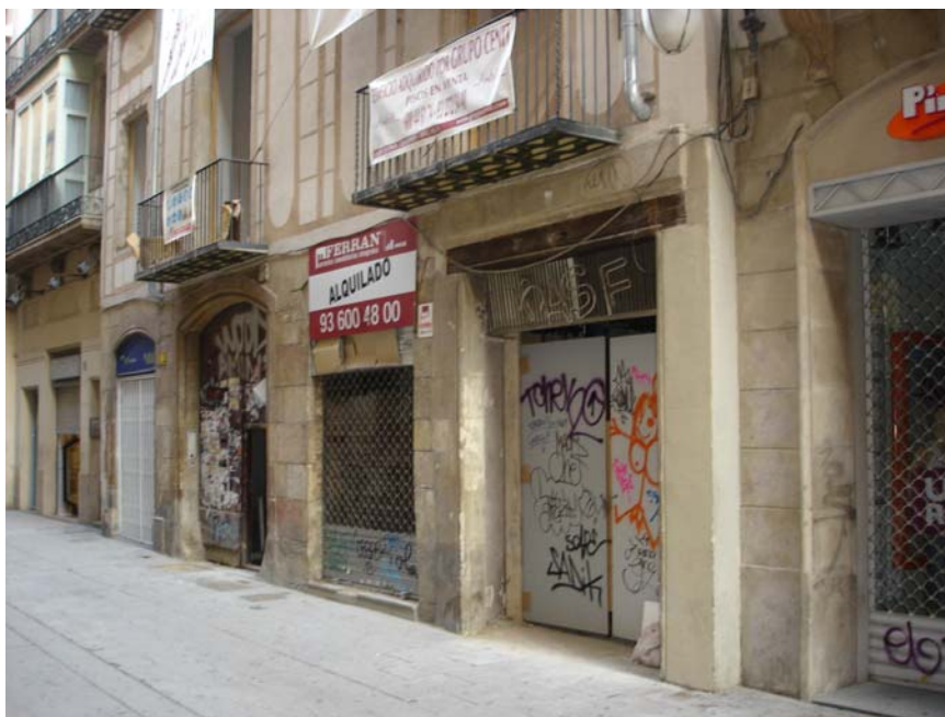
Vista actual de la façana en la seva planta baixa i part del primer pis.
