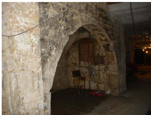
Vista general de l'arcada 1.
